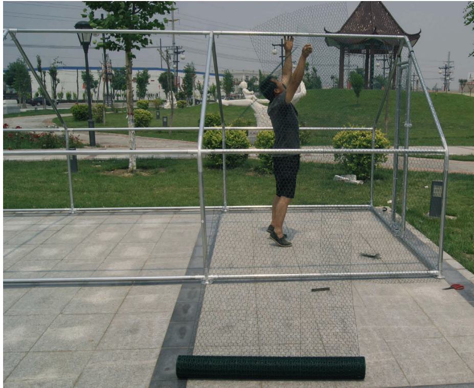
Pose du grillage PVC
